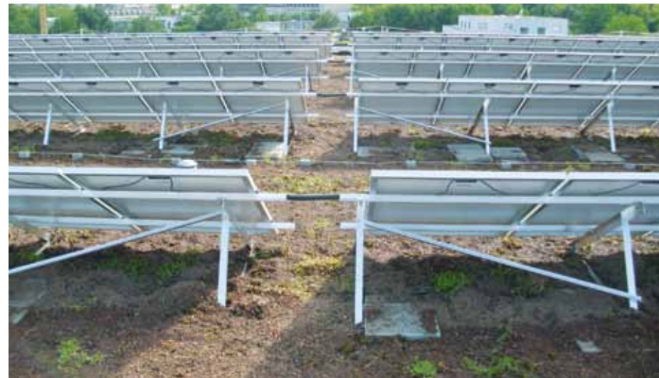
Tittmann Solar | Staatstheater Stuttgart - Allemagne Installation: 112 kW | Système Triangle K2
